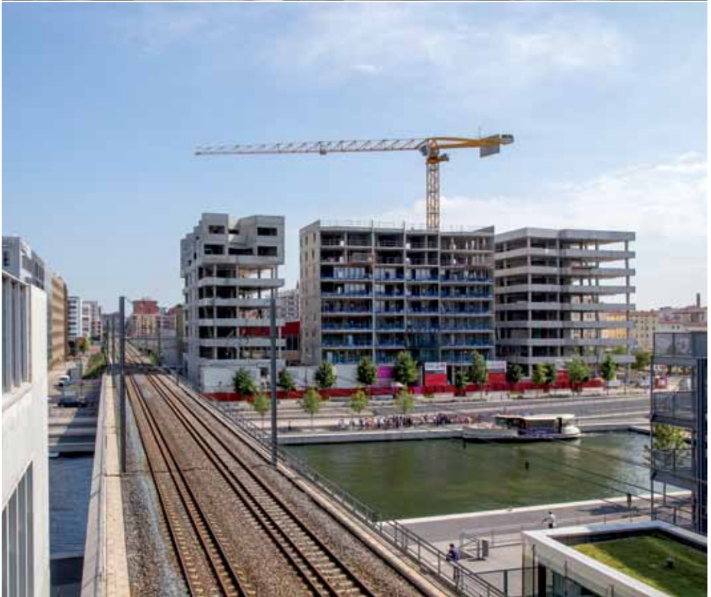
Haut Accueil des nouveaux habitants de l'Escale, du White et du Denuzière (24 septembre 2014). Bas Chantier d'Hikari (août 2014).
