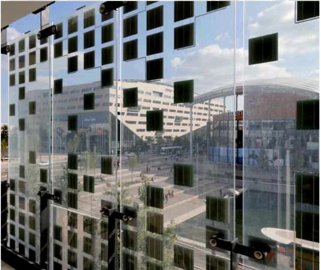
Haut Cité Perrache. Bas « Hikari »: mise en place des panneaux photovoltaïques en façade (septembre 2014).
