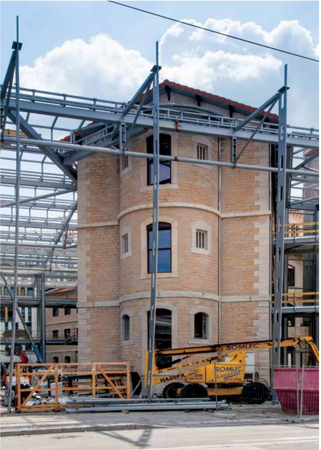
Haut Chantier de « La vie grande ouverte » (août 2014).
