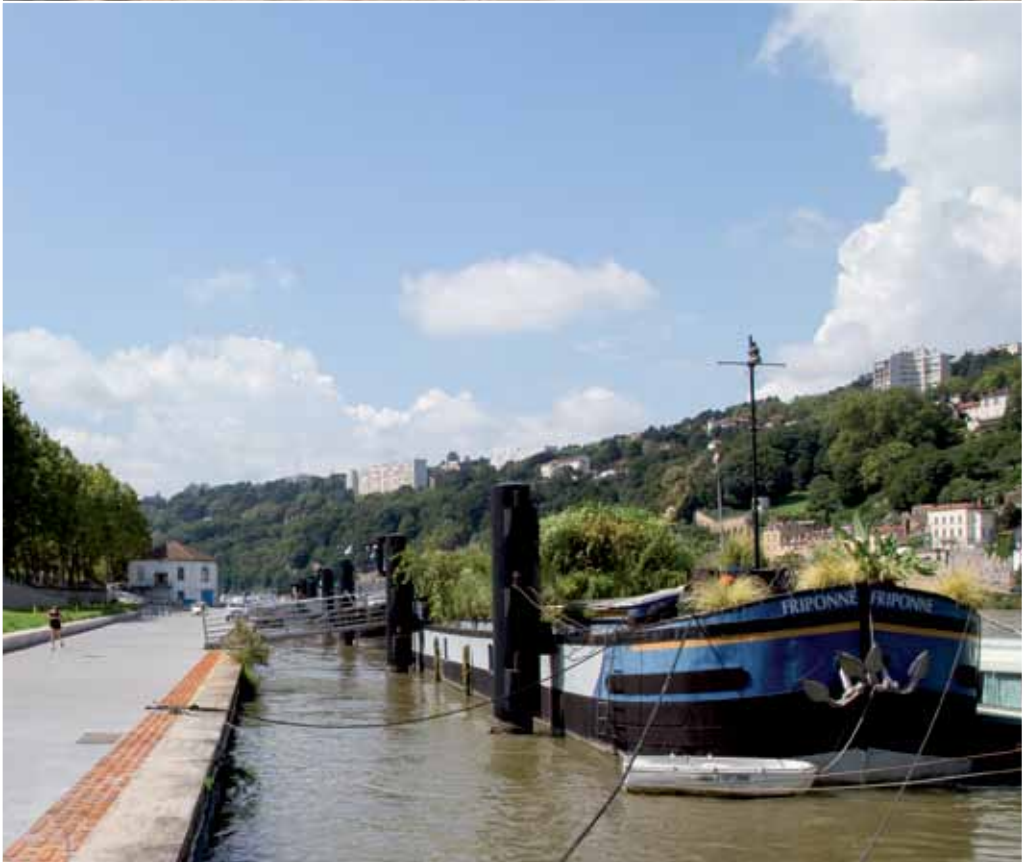
Haut Chantier des Rives de Saône (juin 2014). Bas Rives de Saône (août 2014).
