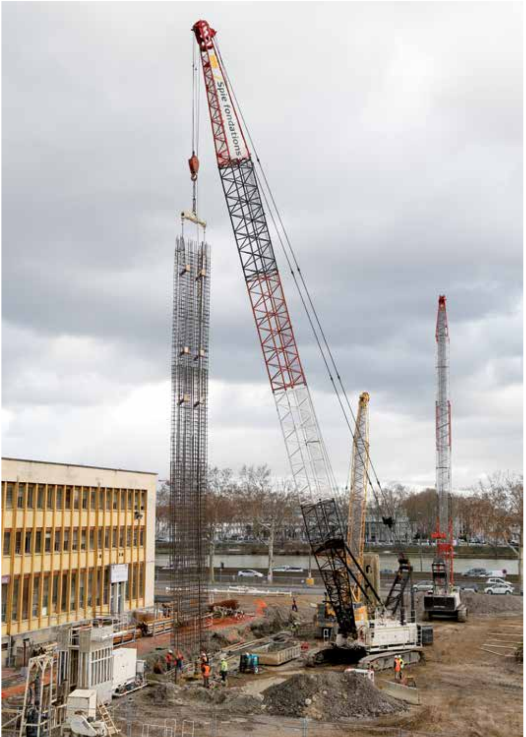
Haut Travaux du futur parking mutualisé du quartier du marché.
