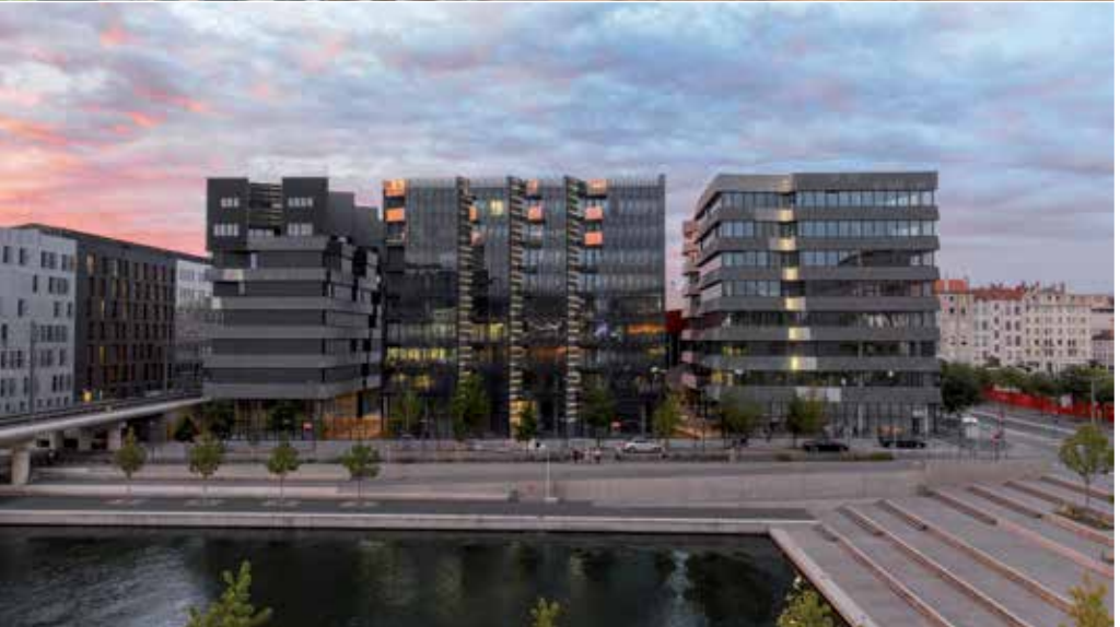
Haut Visite d'Hikari, dont les façades sont composées de cellules photovoltaïques. Bas Hikari est le premier îlot à énergie positive d'Europe.
