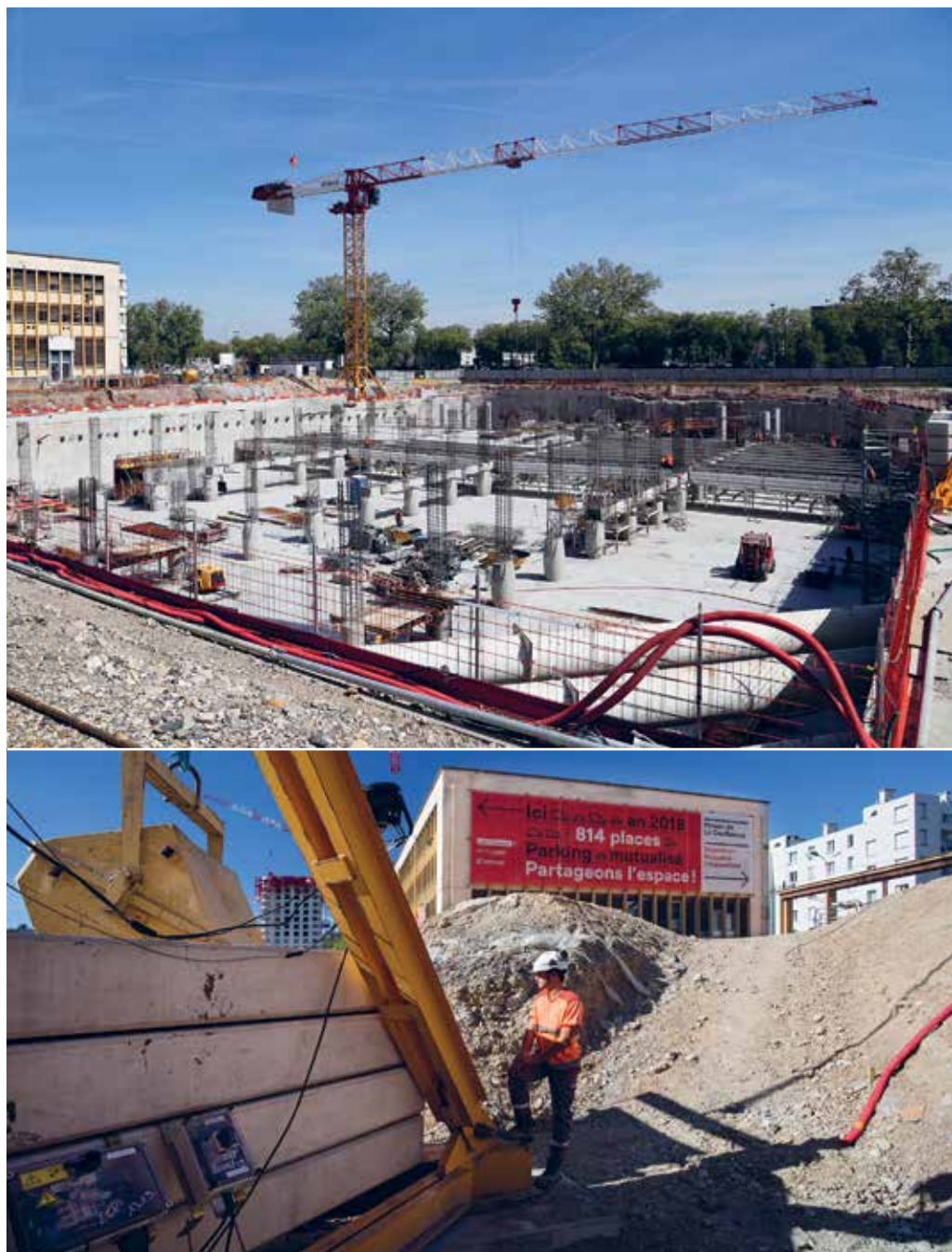
Le creusement du parking mutualisé de 814 places : un chantier de grande envergure.
