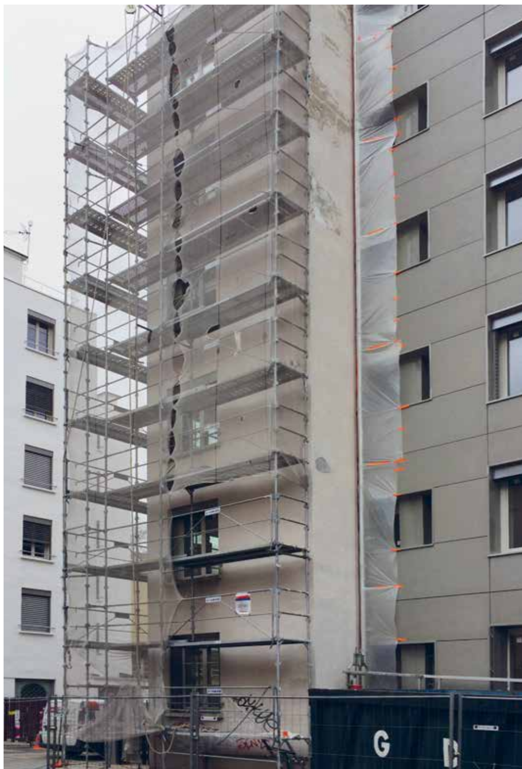
Travaux d'éco-rénovation de la Cité Perrache.
