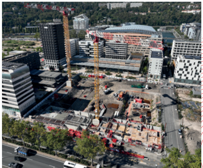
Chantier C1 Nord (2023)
